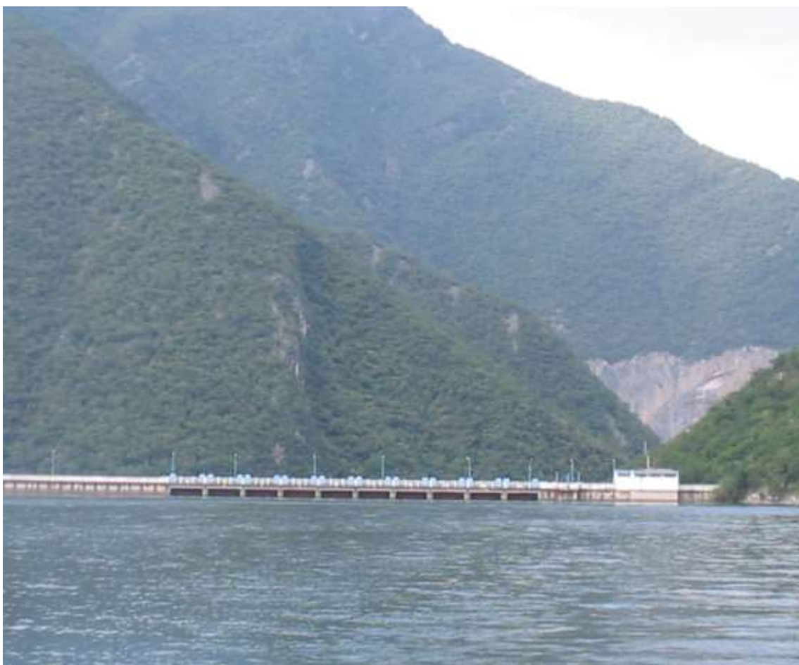
PRESA RODRIGO GÓMEZ O PRESA DE LA BOCA
